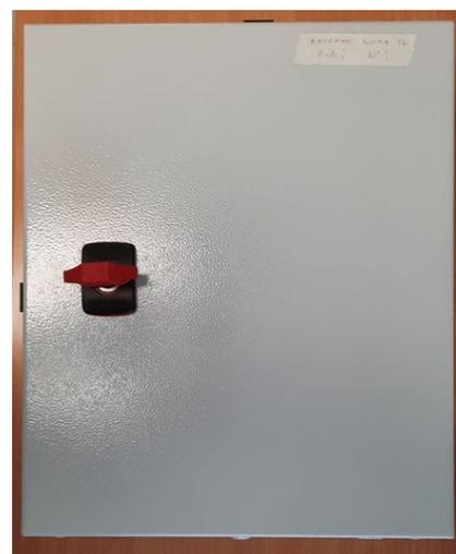
Ce coffret sera protégé par la mise en place d'un disjoncteur installé en tête de tableau divisionnaire (TD Bâtiment) par un disjoncteur 10A Courbe C avec Icc < 20kA Type Schneider iC60N 2P 10A.
