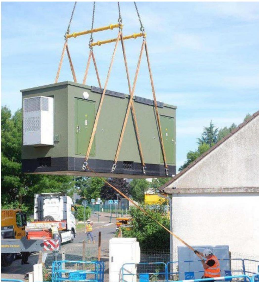
*Le nœud de raccordement optique est déposé par une grue. Il sera connecté au réseau fibre.*
