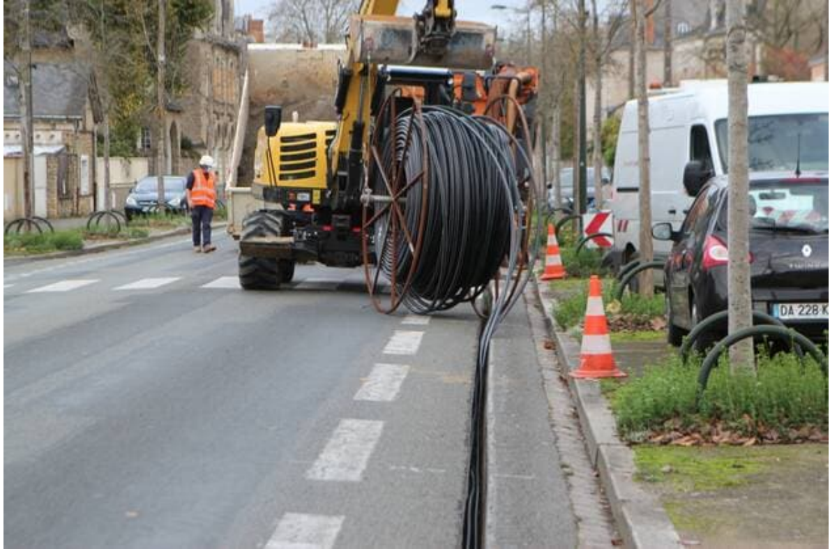
Une micro tranchée a été faite sur le boulevard Latouche. | LE MAINE LIBRE
