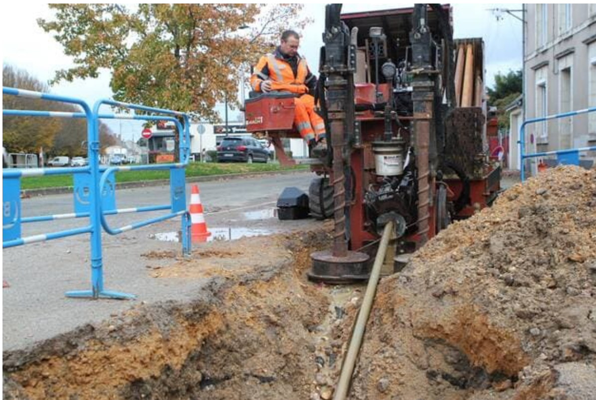
Un gros câble de fibres est déployé depuis un nœud de raccordement basé route de Sablé. | LE MAINE LIBRE
