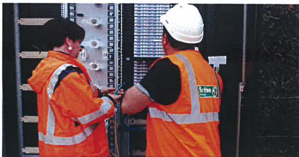
La fibre optique débarque en Sarthe. y compris dans les zones les plus fragiles en matière de numérique.
