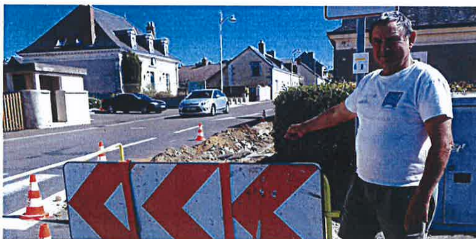
Satisfaction du maire lorsque les travaux de la fibre optique ont débuté ce premier lundi de septembre.
