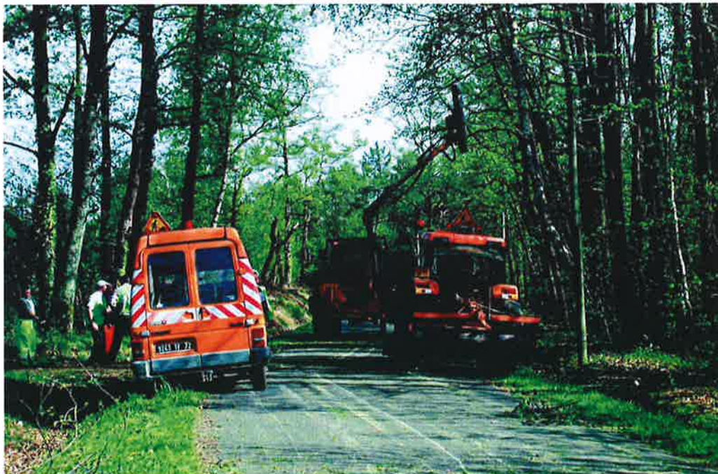
Des travaux d'élagage sont nécessaires pour l'installation de la fibre.
