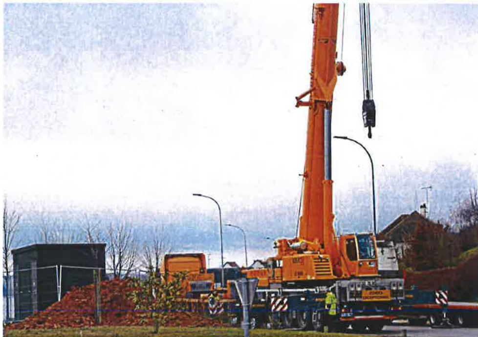
À gauche de la photo L'armoire contenant le NRO, lors de son installation.
