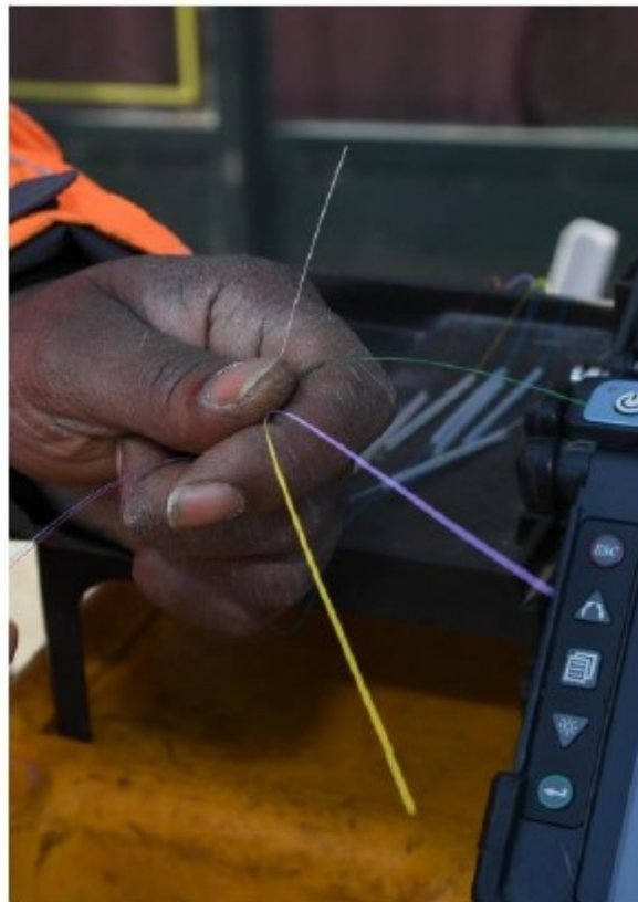
L'installation de la fibre optique se poursuit sur l'ensemble du département.
