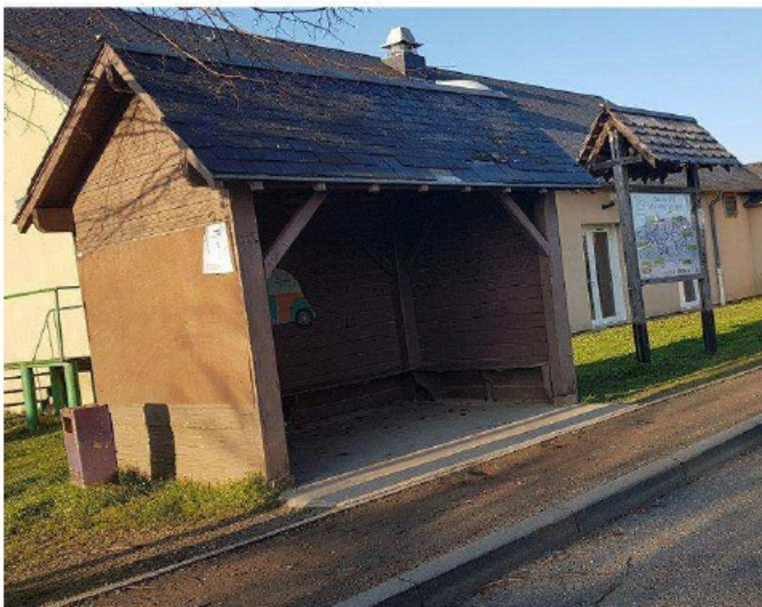
Un nouvel abri de bus sera installé pour la rentrée de septembre près de l'école. Il est actuellement en préparation.
